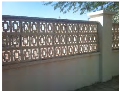
شکل ۵: دیوار مشبک، باعث دید بیشتر از حیاط به بیرون و دید کمتر از بیرون به حیاط می‌شود.
