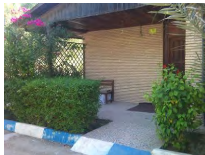
شکل ۶: تعریف ورودی و ایجاد حریم خصوصی اطراف منازل، سبب نظارت بیشتر ساکنین بر محل سکونتشان است.
